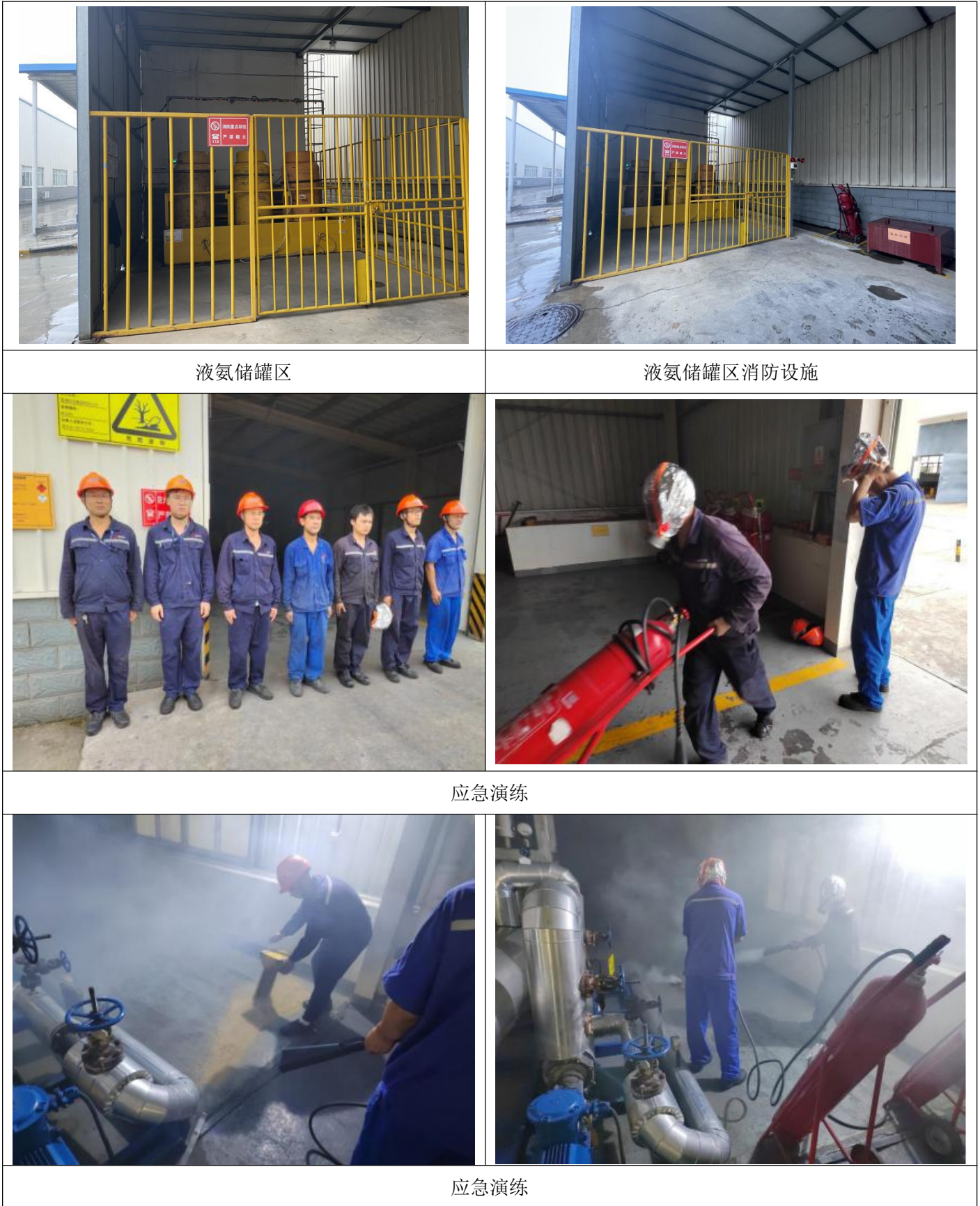
图1-1 原有应急预案中整改措施落实情况照片和企业现状
