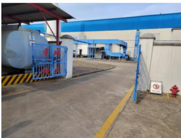
班组支援人员到现场后立即打开油库大门疏散警戒
