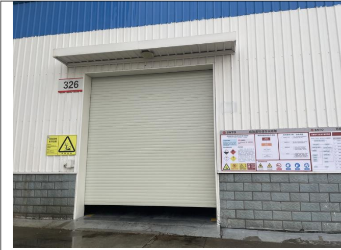
危险废物储存间和看板
