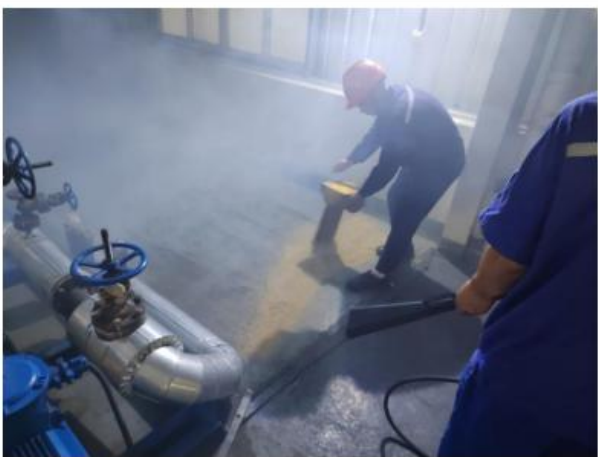
支援灭火人员使用消防沙设置围堰，隔断导热油流动，灭火成功后收集泄漏的导热油
