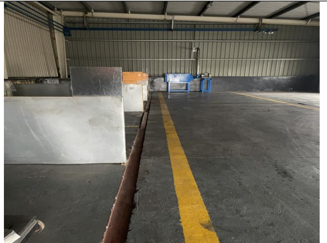
危险废物储存间分区和内部导流沟
